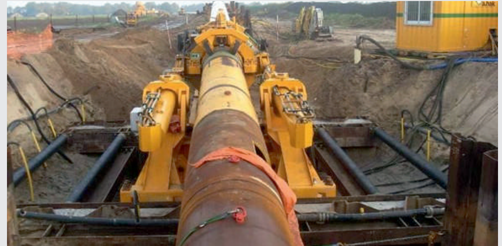
Стартовые котлованы поверхностный
