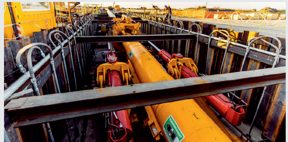
Заглубленный со шпунтом и водопонижением
